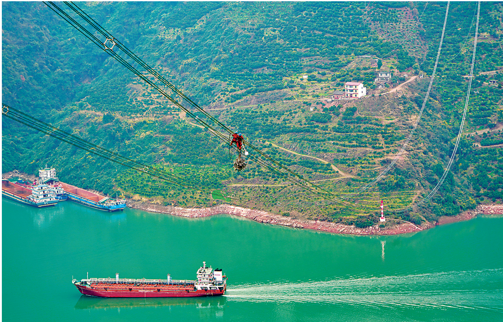
1月10日,在湖北秭归,施工人员在跨越长江的线路上安装间隔棒。白鹤滩—江苏±800千伏特高压直流输电工程于2020年12月开工。工程线路全长2087公里,途经四川、重庆、湖北、安徽、江苏,新建白鹤滩、虞城2座换流站。工程额定电压±800千伏、额定输送容量800万千瓦,总投资307亿元,计划于2022年建成投运。
