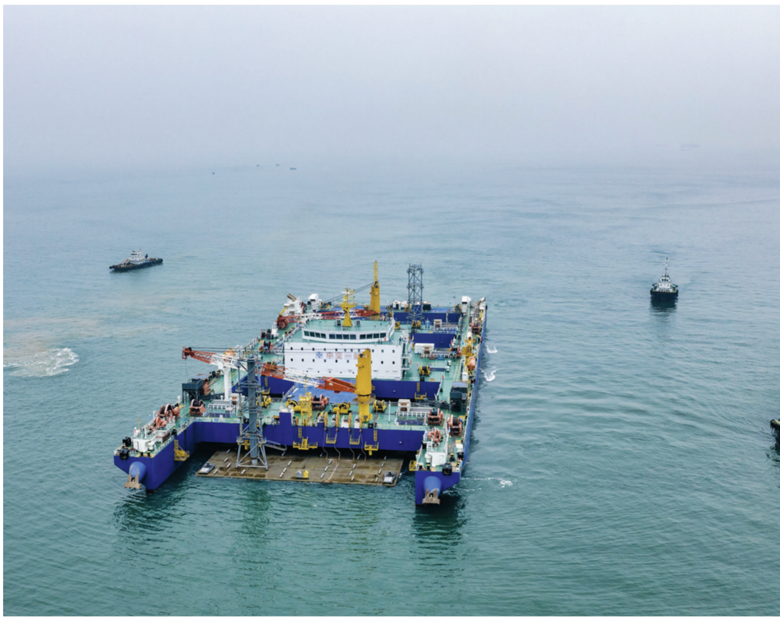
1月14日，中交一航局的“一航津安1”号沉管运输安装一体船搭载E16管节准备浮运前往珠江口伶仃洋安装现场。
