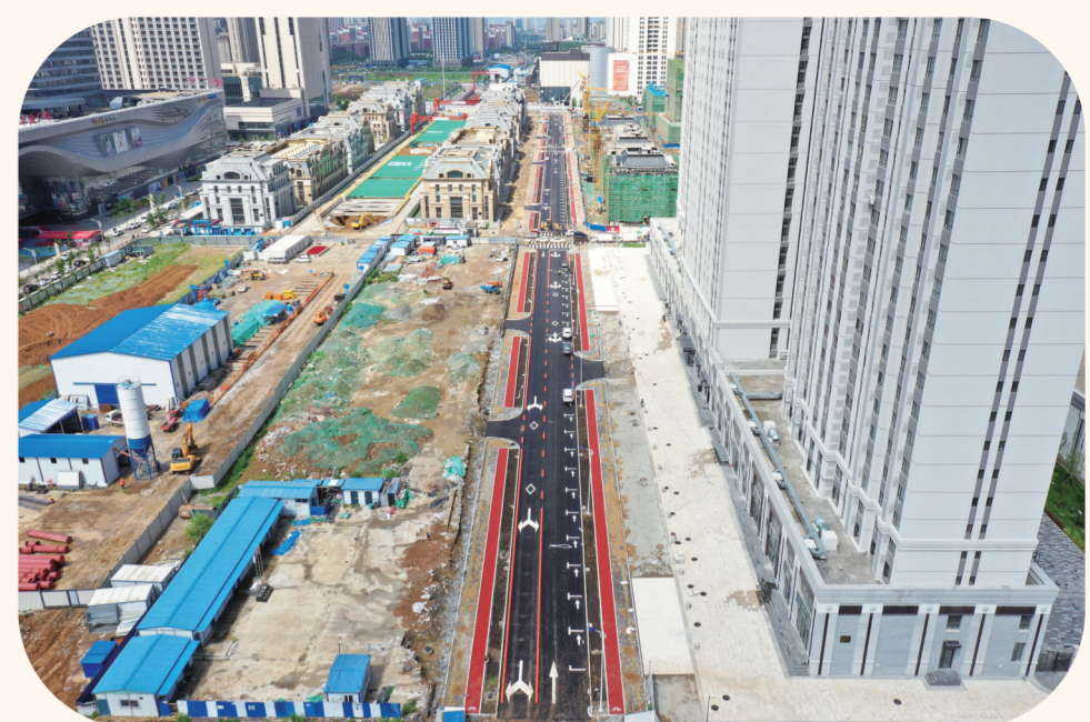
南部新城丙四十四路完工
