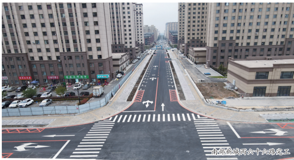
小南街道丙六十六路完工
