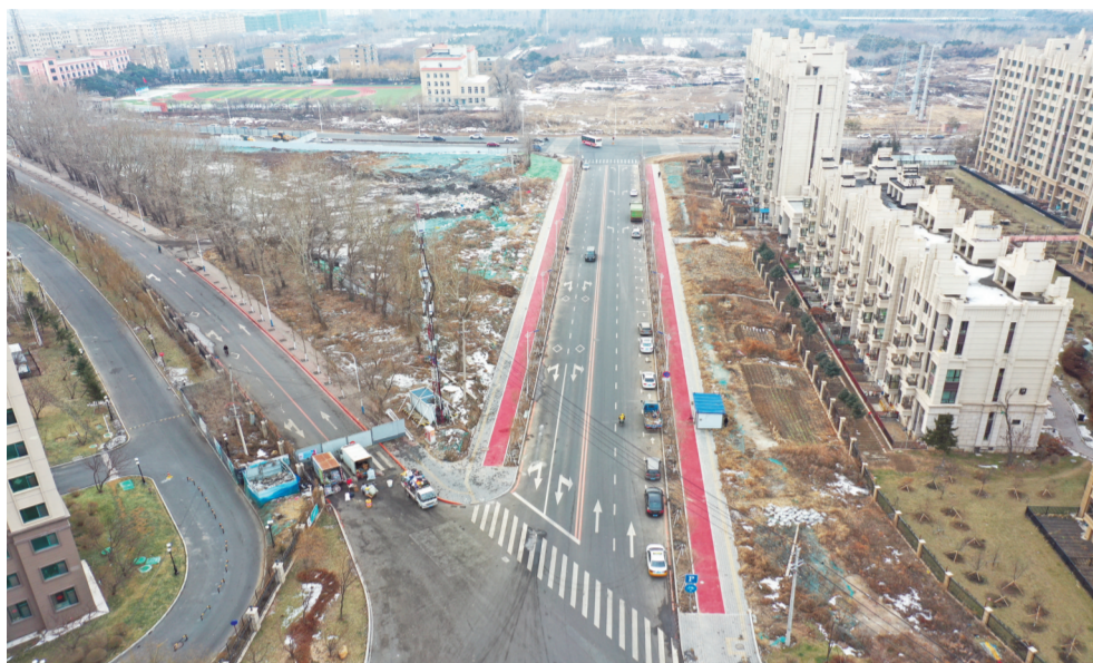
南部新城幸福街完工
