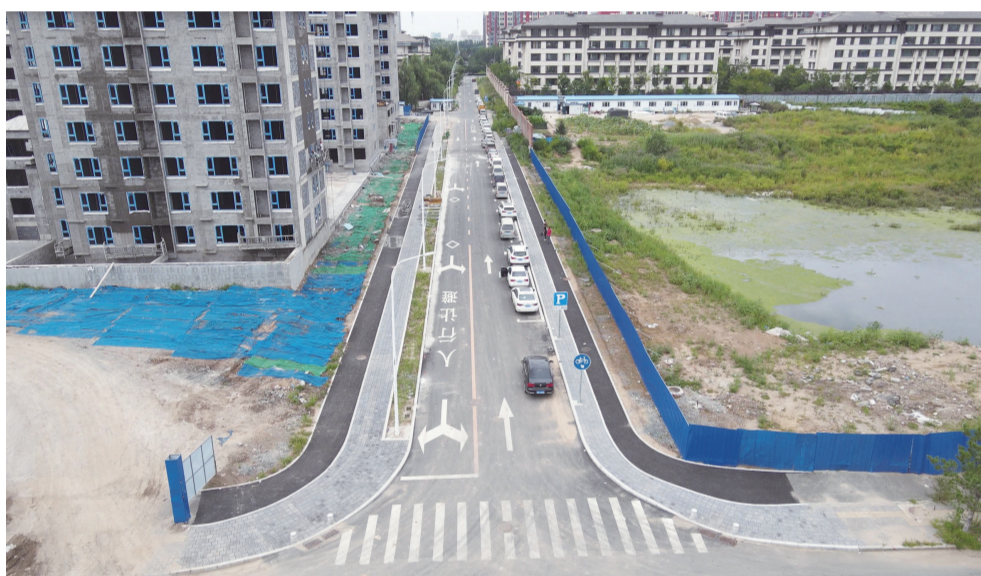
南部新城丙三十七路完工
