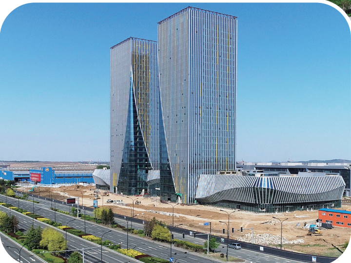
长春兴隆综保区双创总部基地
