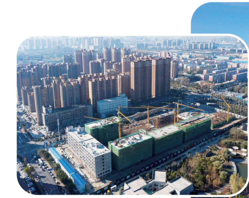
宽城区熙旺中心项目
