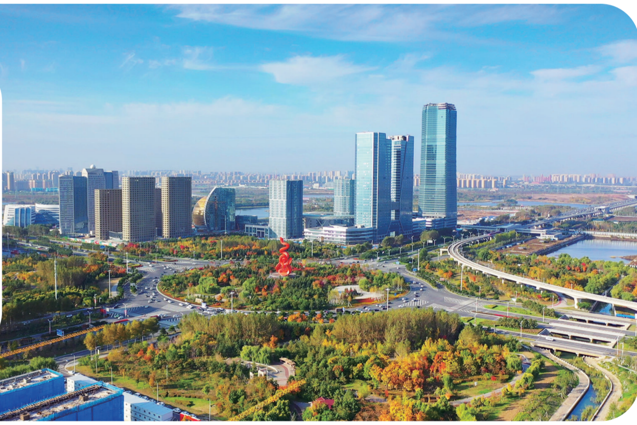
长春新区龙翔商务中心项目
