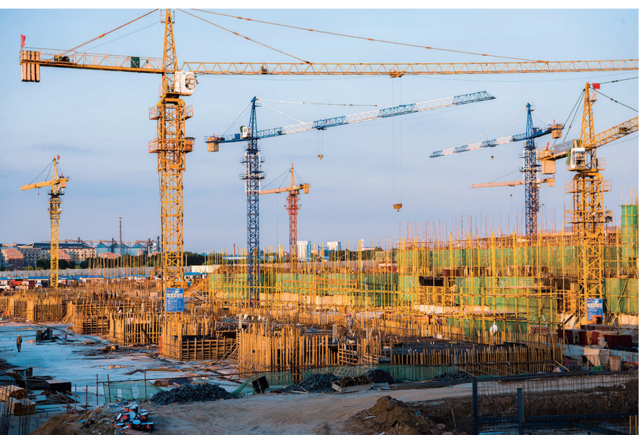
←公主岭市正在建设中的岭西新城区
