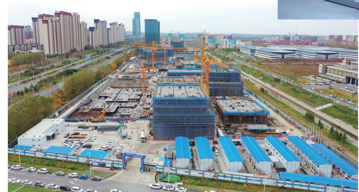
长春新区智能光谷产业园项目
