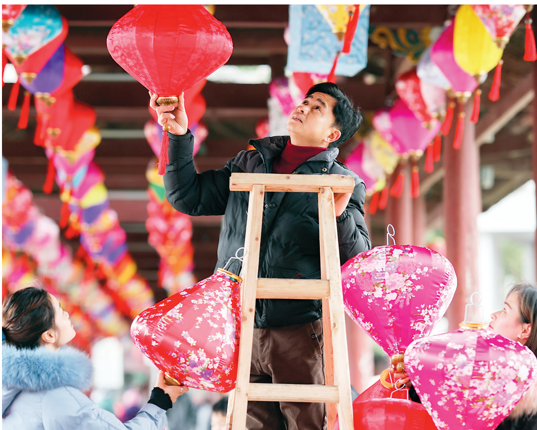
1月24日,在湖南省怀化市通道侗族自治县双江镇,工作人员在一座风雨桥上挂花灯。虎年春节前夕,在湖南省怀化市通道侗族自治县,人们纷纷对风雨桥等具有当地特色的场所进行美化装饰,挂上喜庆的花灯,迎接新春佳节到来。
