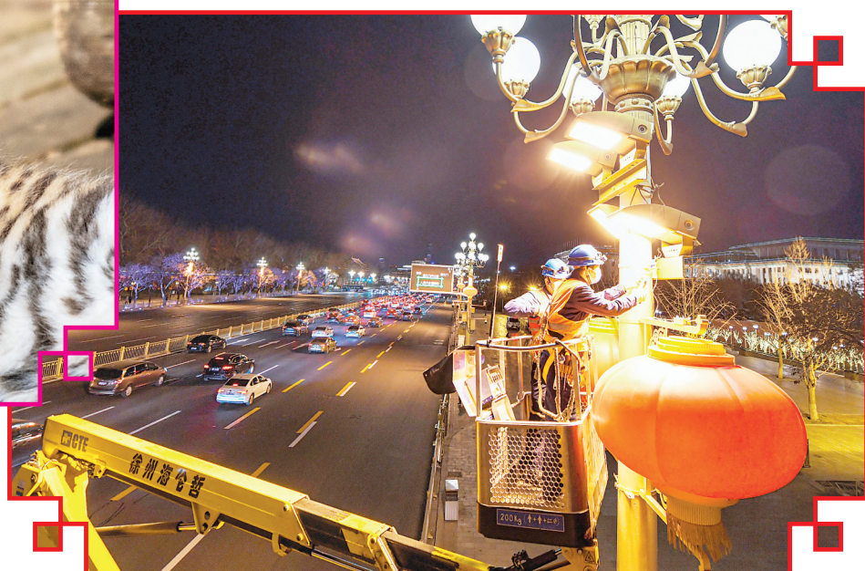
1月30日，北京城市照明中心的工作人员在维护长安街上的节能型大红灯笼。春节临近，北京城市照明管理中心在长安街等主要街道安装了1000多套节能型大红灯笼和中国结。新华社 张超 摄
