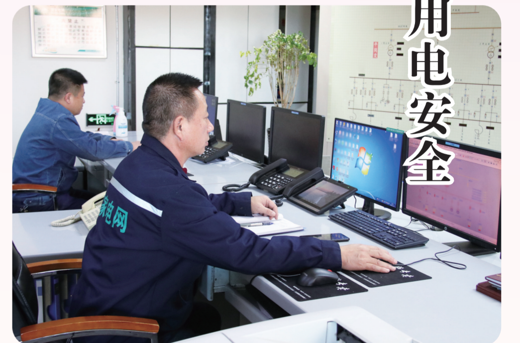
2月3日，东辽县供电公司工作人员在调控中心指导协调所辖9座66千伏变电站和52条10千伏配网线路安全稳定运行。李亚南 摄
