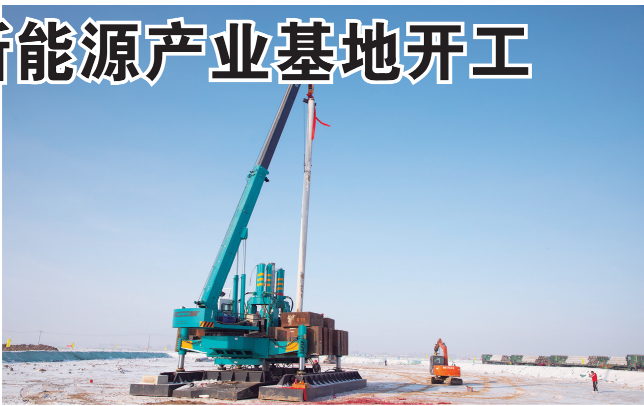
基地建设打桩现场。
