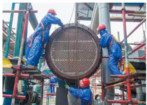
吉林石化作业人员在装置现场做换热器打压试漏。
