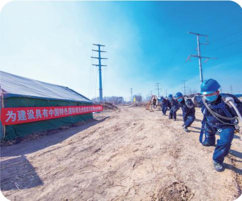
国网长春供电公司员工对海河66千伏输电工程进行挂线作业
