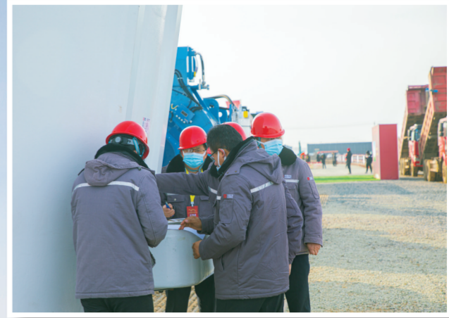
施工人员现场研究方案。
