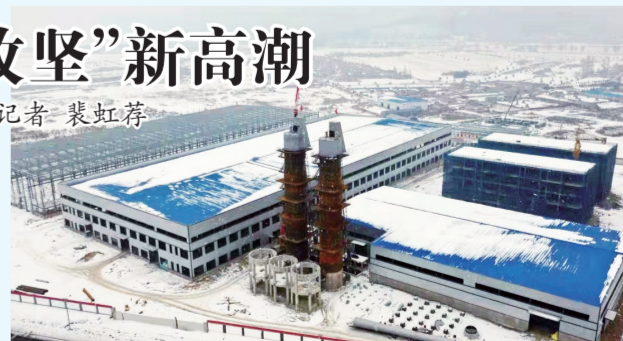
鑫鸿年产300万吨环保新材料产业基地项目已于2月12日复工,目前正在进行设备安装。刘世博 摄
