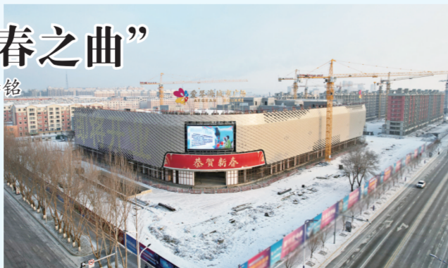
辉南县爱琴海城市广场项目建设现场。马玉瑶 摄
