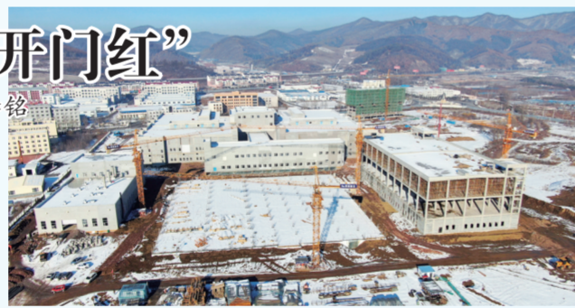
通化安睿特生物制药股份有限公司重组人白蛋白产业园一期工程项目现场。高亚男 摄
