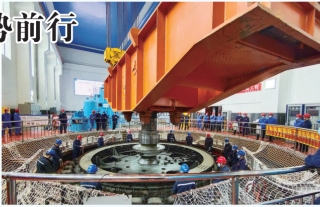
集安市云峰电厂网3号发电机组改造项目正在施工。李润泽 摄
