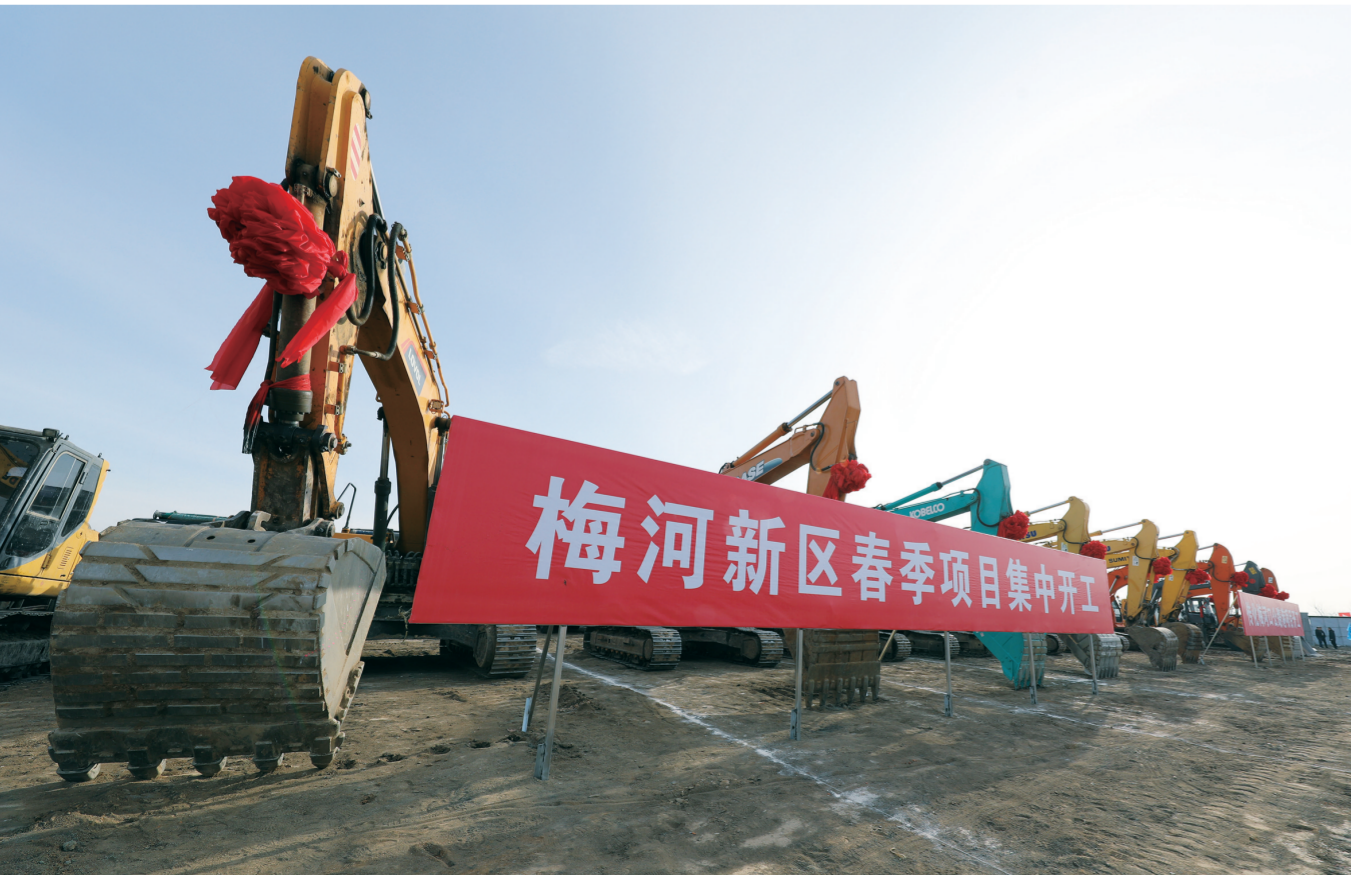
大型机械设备即将投入“主战场”。尹航摄
