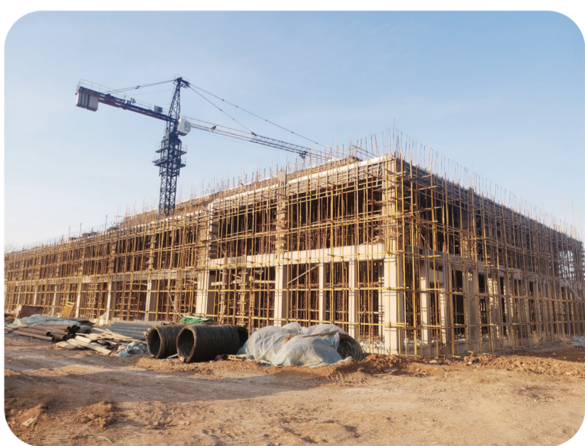
四平—长春共建汽车产业园项目建设现场一角。干健摄
