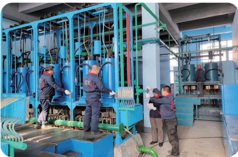
年产6亿元光伏用钨丝建设项目进入设备调试阶段。王健摄
