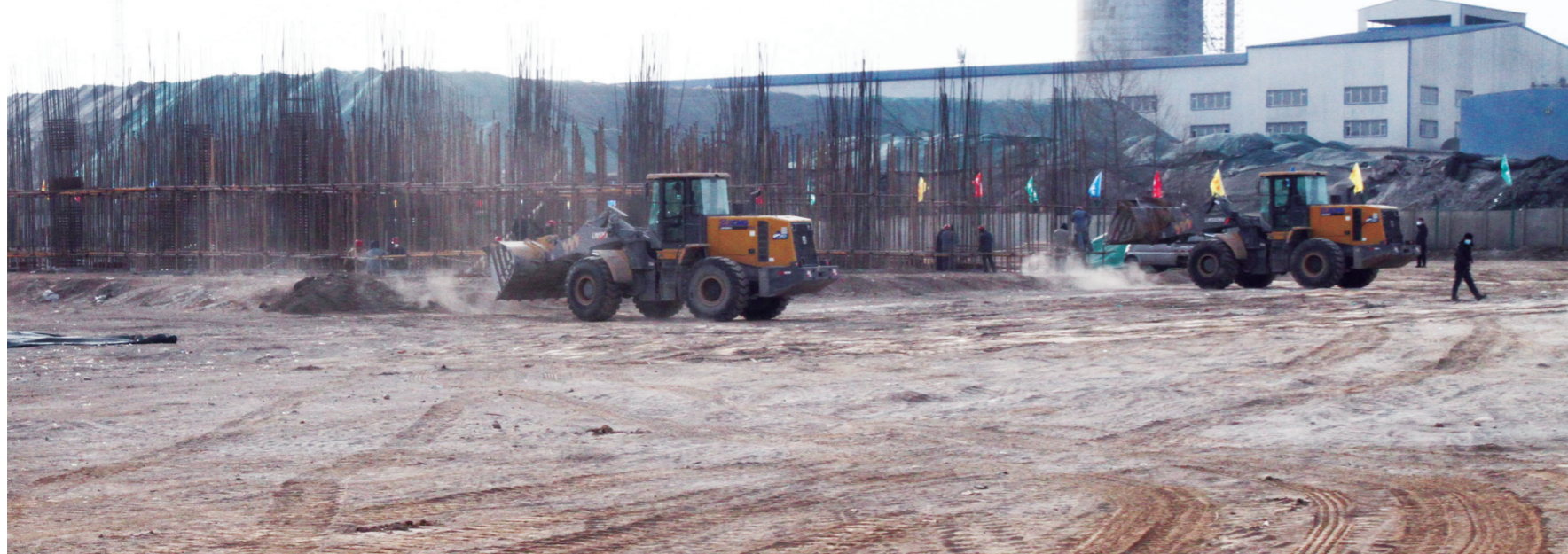
年产60万吨矿渣微粉建设项目开工现场。袁松年摄
