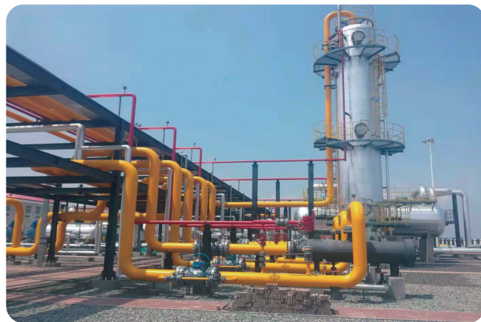
双坨子储气库项目
