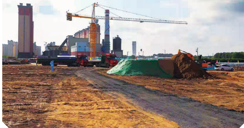
扶余中医院建设项目
