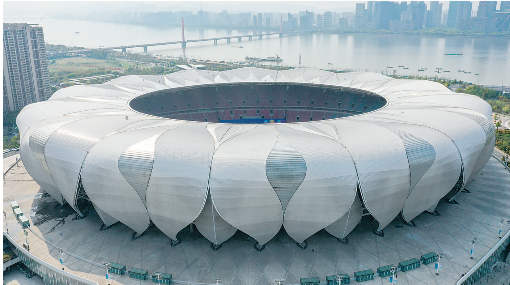
这是2022年3月30日拍摄的杭州奥体中心体育场(无人机照片)。3月31日,绍兴棒(垒)球体育文化中心、绍兴柯桥羊山攀岩基地先后通过赛事功能验收。至此,历时近5年建设后,杭州2022年亚运会、亚残运会56个竞赛场馆全面竣工并通过赛事功能综合验收。
