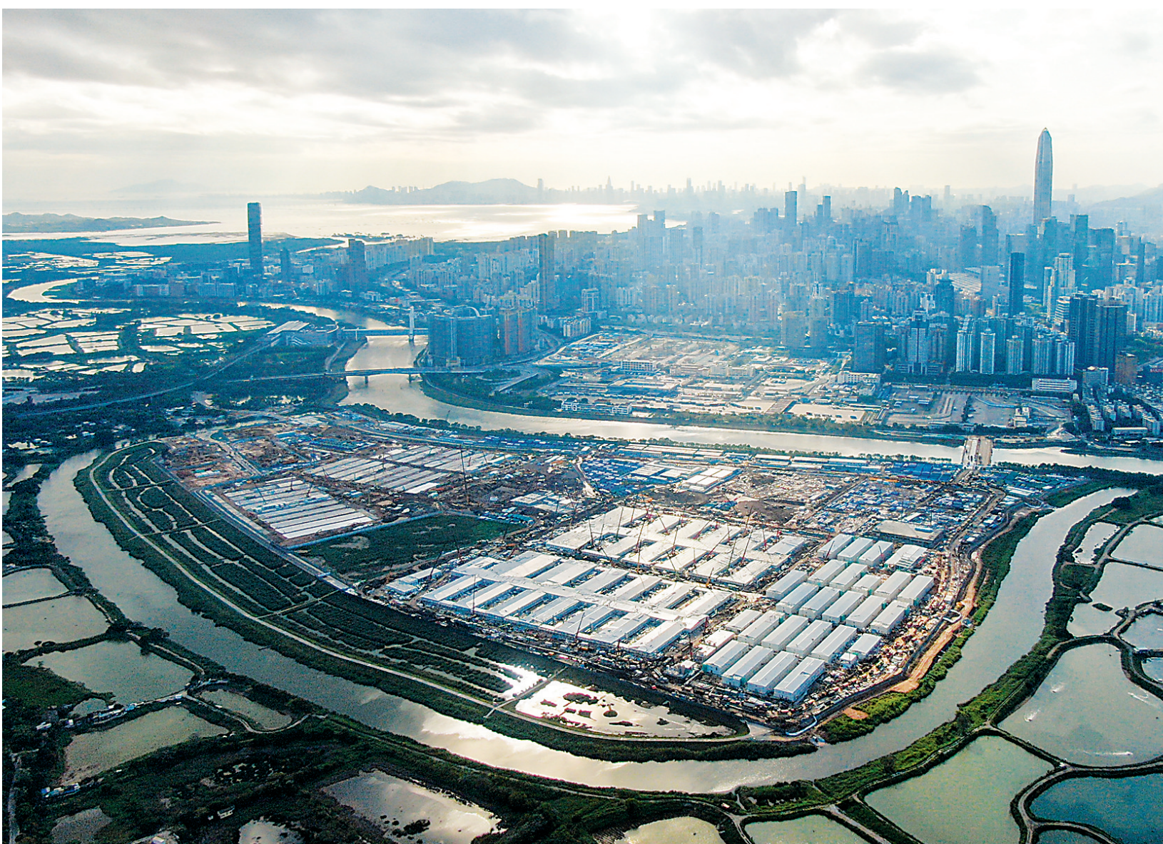
3月30日,雨后天晴,阳光透过云层照在中央援港应急医院建设工地上(无人机照片)。经过30天争分夺秒日夜奋战,位于香港落马洲河套地区的中央援港应急医院项目一期工程按期完工并通过验收,4月7日举行了竣工交付仪式,正式投入使用后可提供500张负压床位。 新华社记者 梁旭 摄
