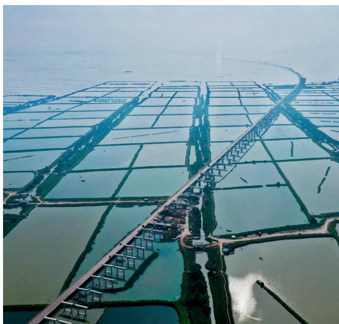
5月6日拍摄的黄茅海跨海通道建设现场(无人机照片)。目前，中铁十一局参与建设的黄茅海跨海通道工程建设进展顺利。项目预计2024年建成通车。建成通车后，将与港珠澳大桥、深中通道、南沙大桥、虎门大桥共同组成粤港澳大湾区跨海跨江通道群，加快大湾区形成世界级交通枢纽。
