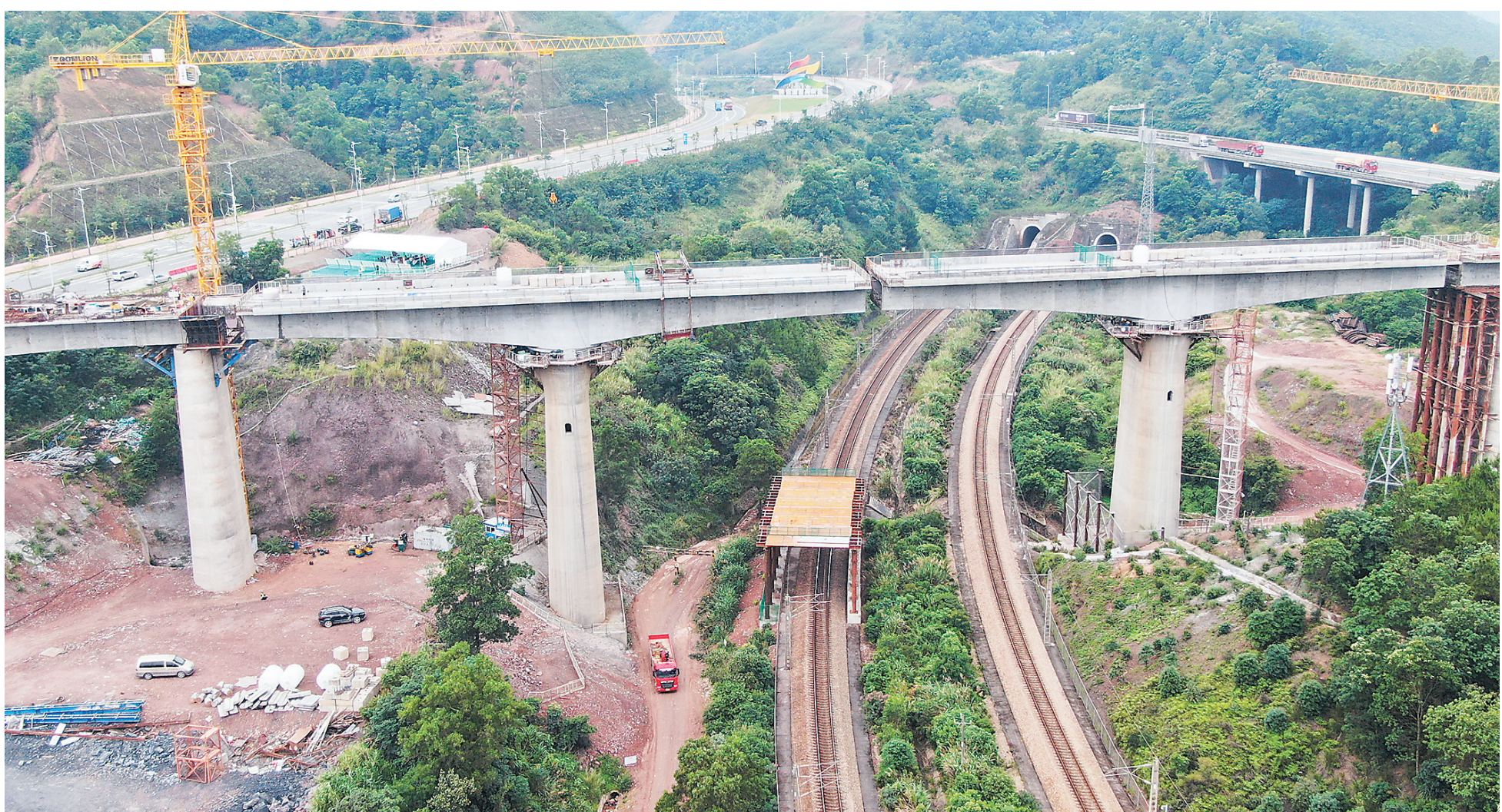
图为转体后的广汕高铁跨京九铁路特大桥连续梁(5月9日摄,无人机照片)。5月9日凌晨,由中铁二局集团承建的广汕高铁跨京九铁路特大桥连续梁成功转体77度,在距京九铁路轨面33.4米的高空中实现精准对接。广汕高铁全长约206公里,设计时速350公里/小时。
