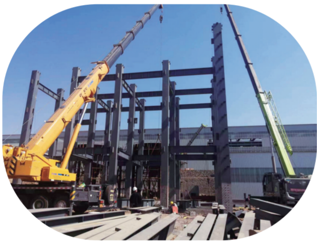
中溢集团年产30万吨新能源负极材料工序项目，正在进行钢结构吊装。崔雪摄
