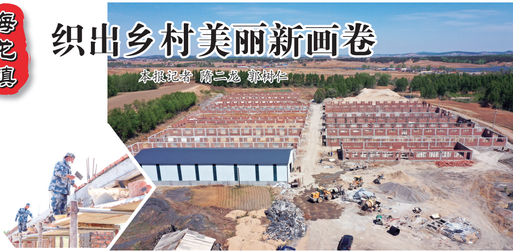
大规模养猪场火热施工中。
