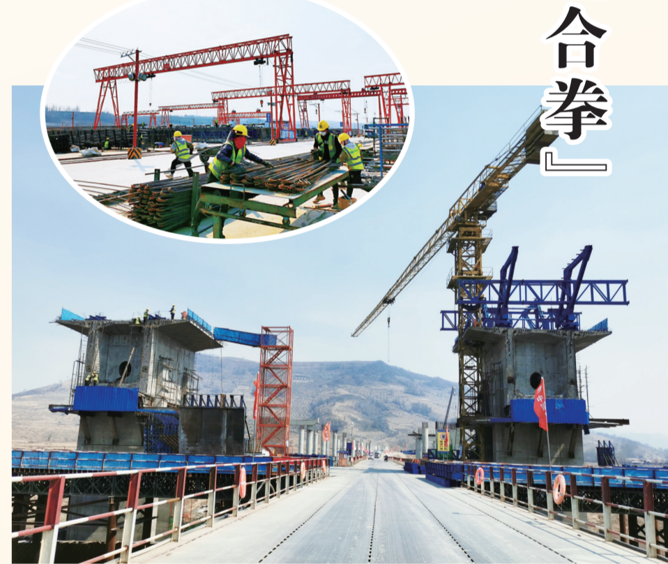
延长高速(桦甸段)蒲烟工区建设现场
