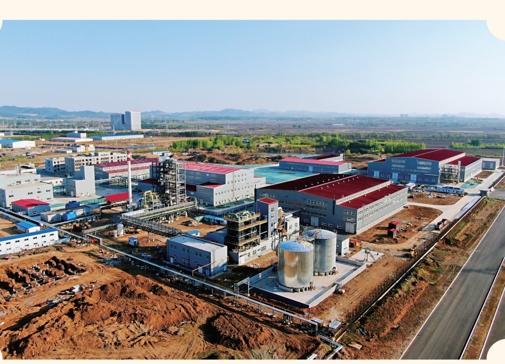
总投资65亿元的中泽吉铁铜深加工项目现场
