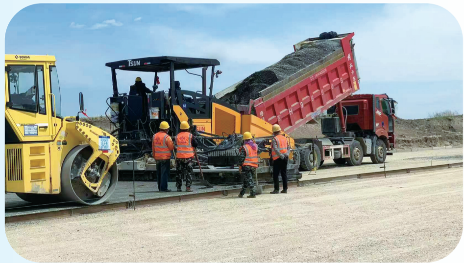
长春市环线九台至双阳段抢抓工时,加快建设。
