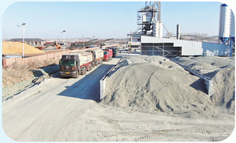
长太高速公路组织点对点运输,备足施工材料。
