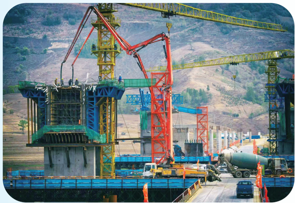
蒲烟高速公路桥梁等重大节点工程全面加快建设。
