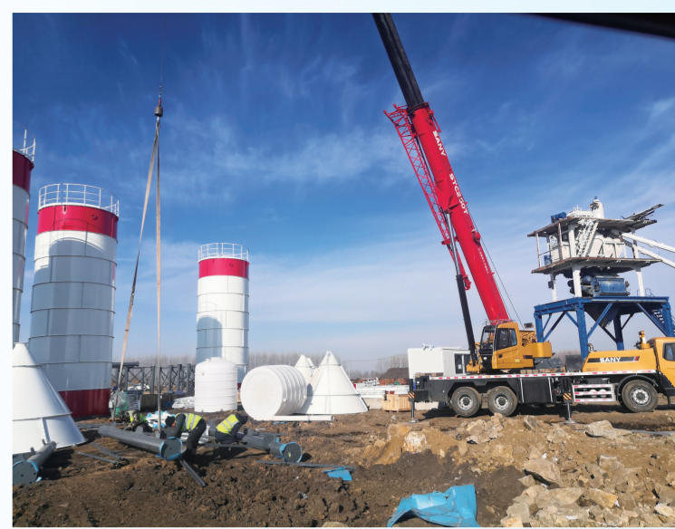
长春市环线高速公路农安至九台段关键工序24小时循环作业。
