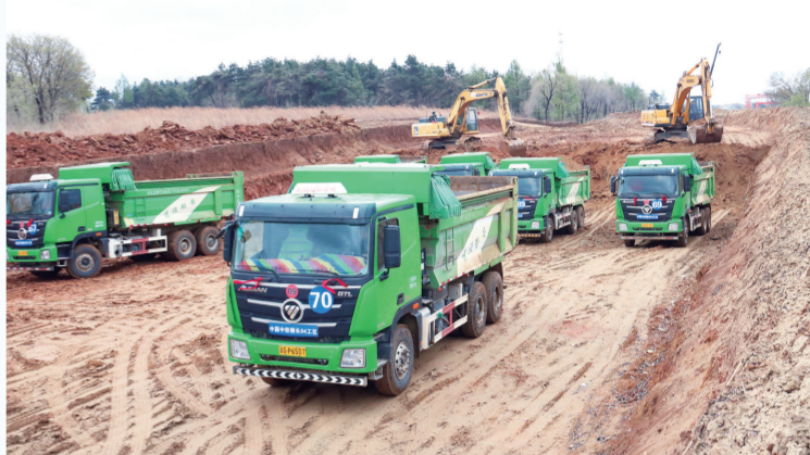
烟长高速公路900余套机械设备不间断作业。
