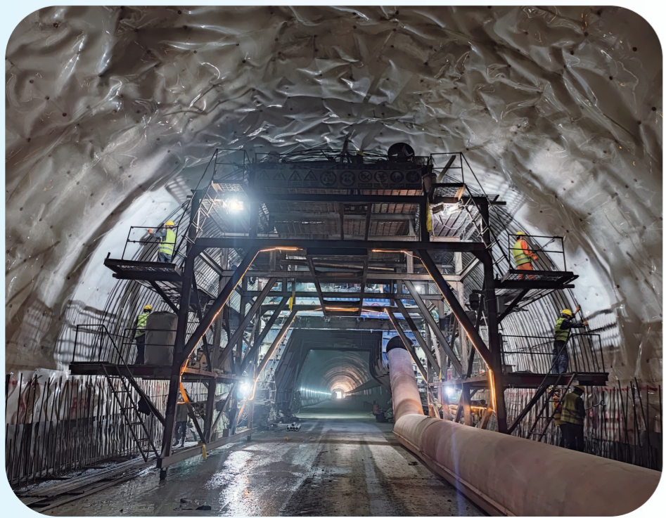
蒲烟高速公路隧道施工持续加快推进。
