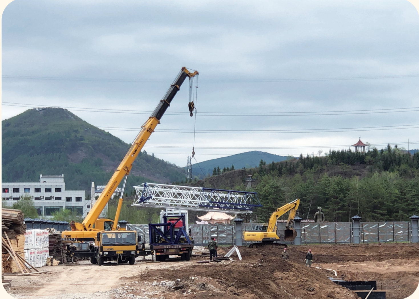
融媒双创产业园项目是安图县重点项目之一,该项目于今年4月动工,预计年末完成主体建设。项目总投资1.08亿元,总用地面积2.7万平方米。项目内设地方主流媒体基地,创业中心,5G展示中心等数字产业基地,孵化企业办公、文化展示、演播厅等综合服务基地,有效支撑安图县文化产业领域实现转型升级。安图县委宣传部供图
