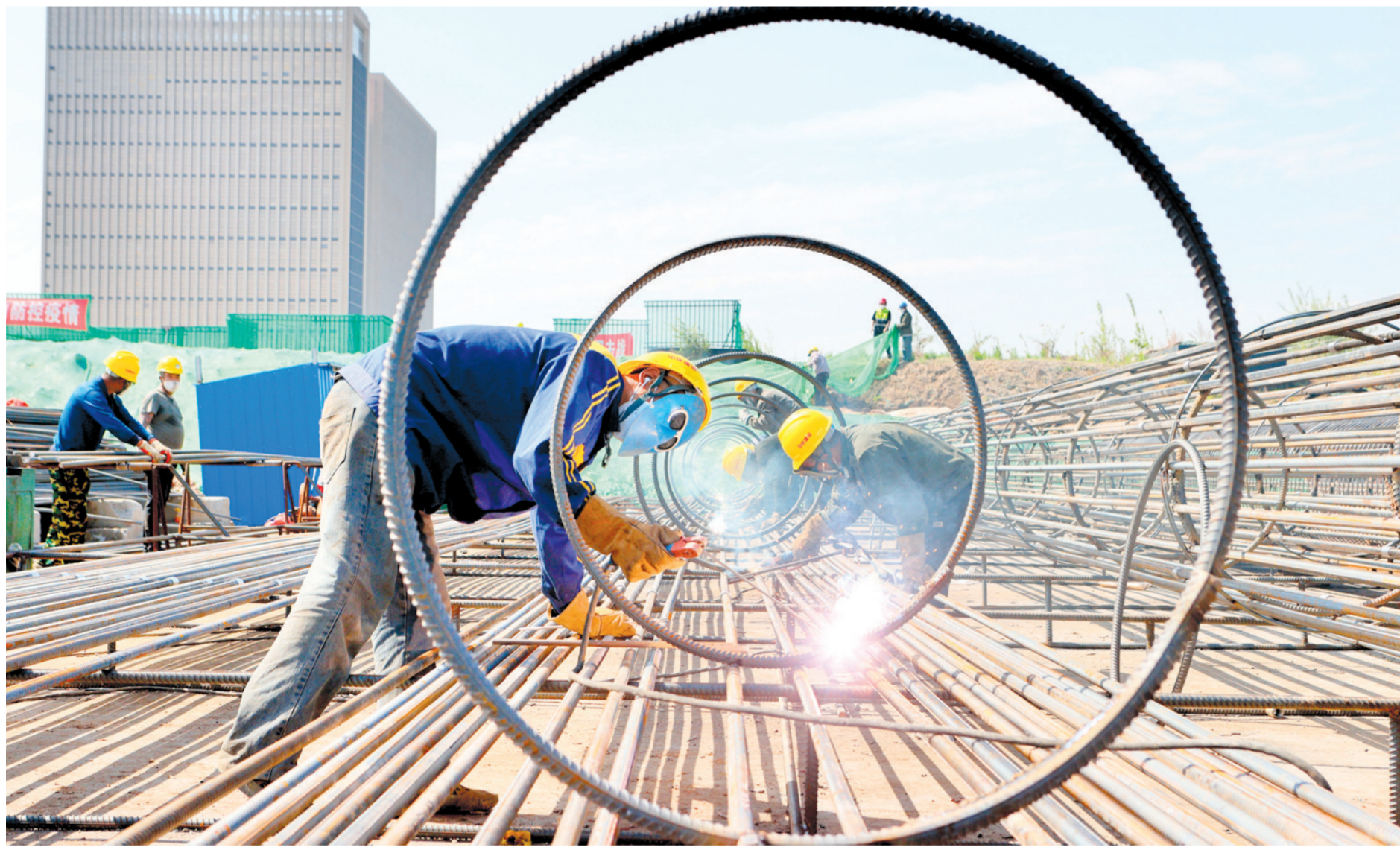
人民大街下穿隧道作为长春市重点基础设施项目，主线全长1.58公里，总投资13.37亿元，竣工后将进一步拓展人民大街城市主轴线功能，对加速长吉高速公路人民大街出口改移和完善南部新城交通路网具有重大意义。这是在施工现场，工人们正紧张忙碌的场面。 本报记者 丁研 摄
