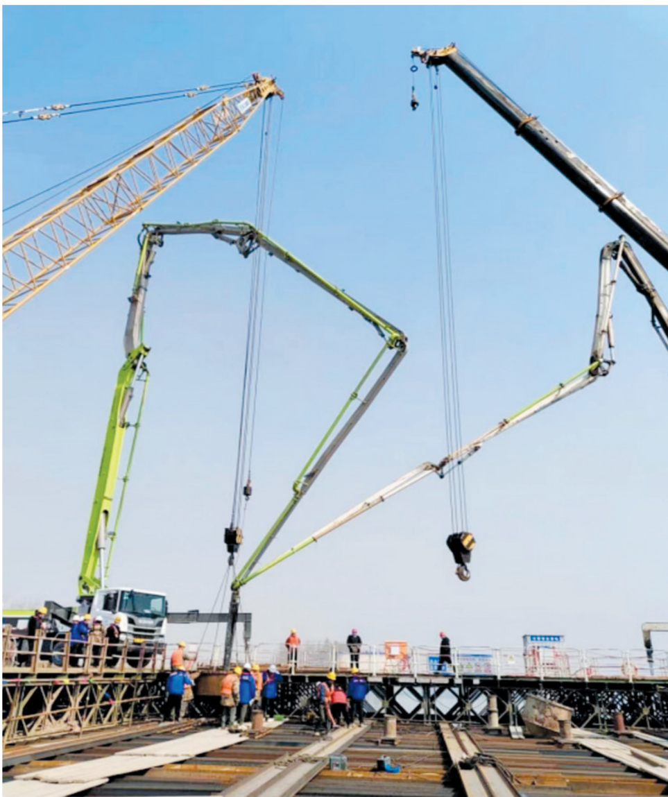
自4月28日我省二季度项目集中开工复工以来，项目建设在省内外如火如荼地开展起来。图为正在建设中的白旗松花江大桥项目。
