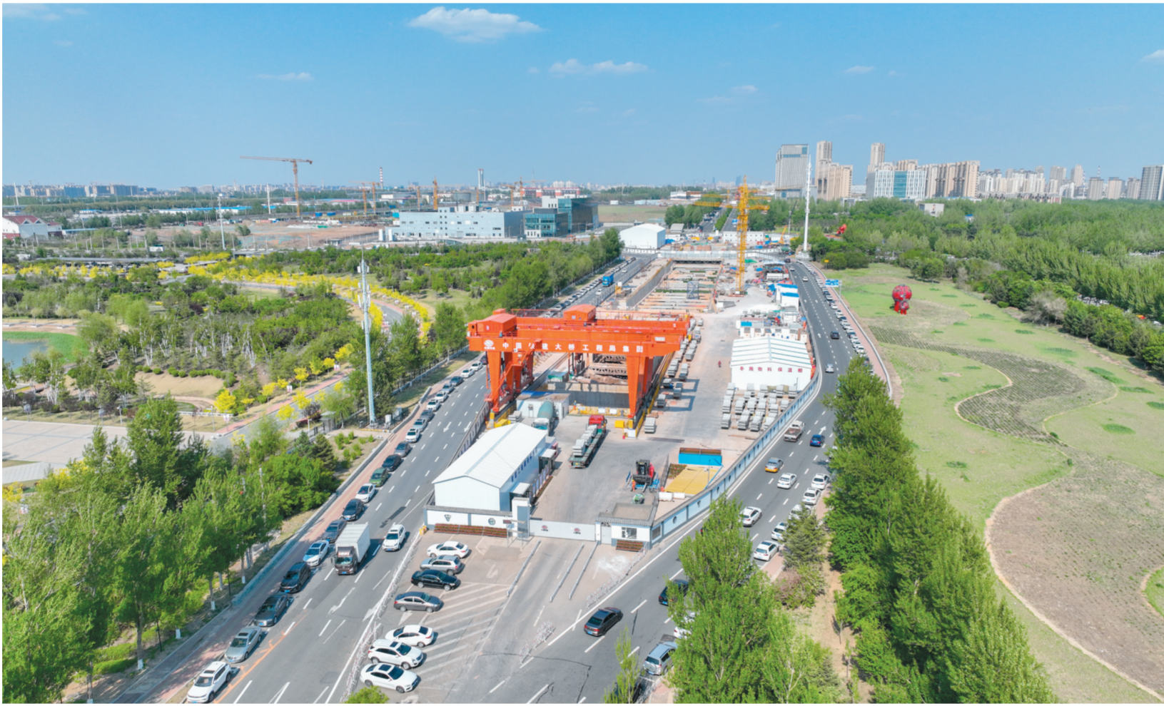
近日，由中铁建大桥局六公司承建的长春轨道交通7号线西四环站主体结构封顶，较原计划提前14天，为完成全年施工任务奠定了坚实的基础。这是施工现场航拍图。 通讯员 付瑞钢 本报记者 丁研摄
