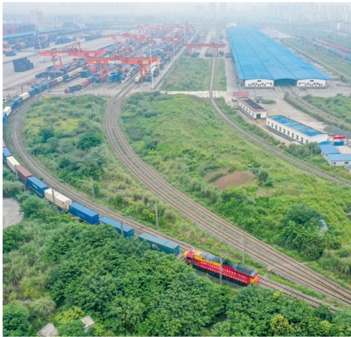
日前,一列满载40台轻卡的中老国际货运班列庆铃汽车专列从重庆团结村车站发车。在重庆海关和昆明海关的联合保障下,该专列将经由磨憨口岸出境,通过铁路联运方式最终运抵老挝万象。这是重庆自实现“铁路快通”双向贯通以来,首趟整列采用“铁路快通”模式出口的中老国际货运班列整车专列。该班列的运行,为重庆本地国产品牌汽车整车出口东盟市场节约货运时效1-3天,降低费用成本,实现“成本+时效”双优的效果。新华社记者 黄伟 摄
