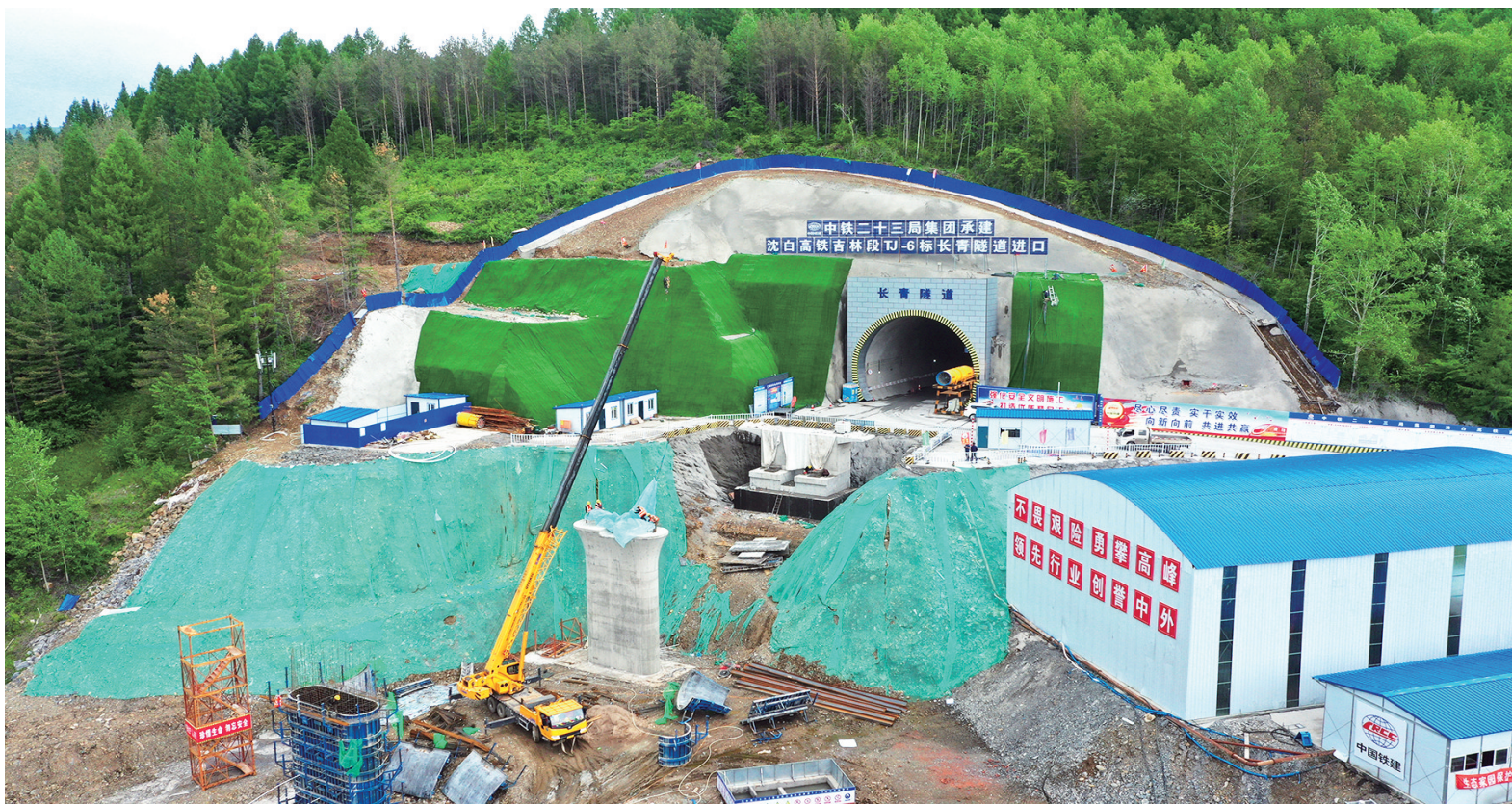
沈阳至白河高铁项目建成,将带动沿线旅游资源开发和产业优化升级。由中铁二十三局集团承建的全线第二长大隧道——吉林TJ-6标长青隧道,争分夺秒保工期、昼夜不停抢进度,目前已累计完成正洞进尺830米。图为隧道进口施工现场。
