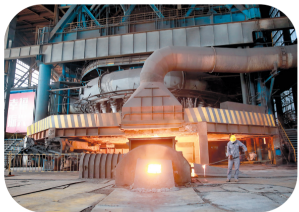
图为通钢炼铁三号高炉生产现场。
