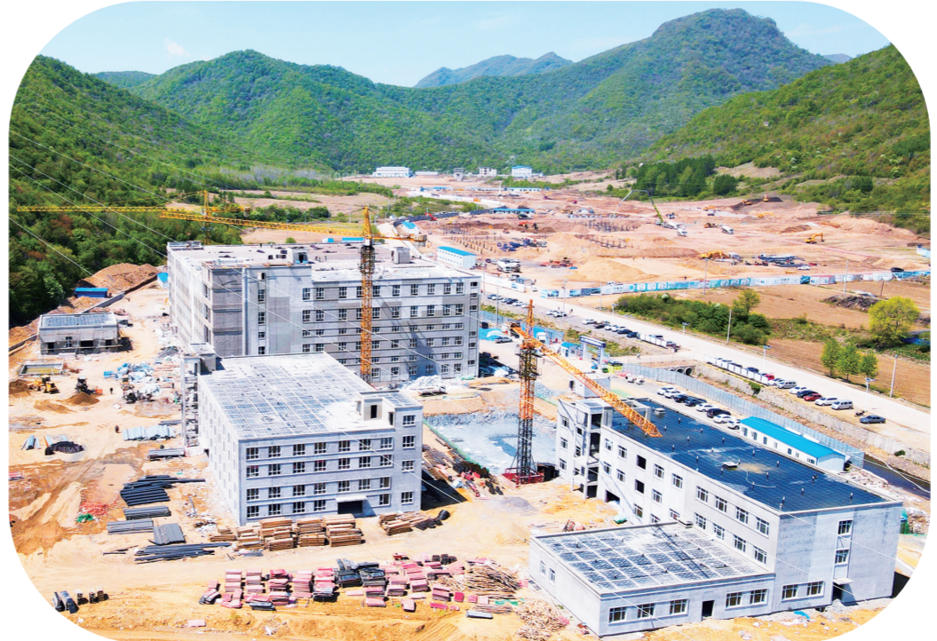
白山市医药高新产业园厂区建设现场。
