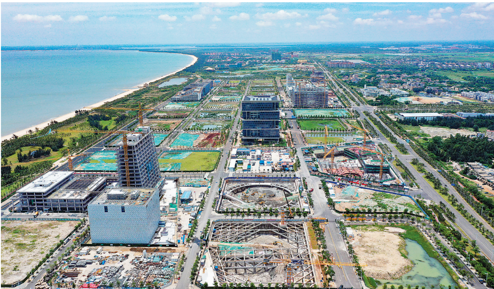
这是6月21日拍摄的海口江东新区总部经济区(无人机照片)。海口江东新区是海南自贸港重点园区之一,2020年6月正式挂牌。总部经济区在建的14个项目中,已有7个项目实现主体结构封顶。新华社记者 郭程 摄
