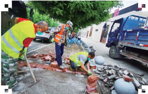
宽城区住建局施工班组正在对人行道破损处进行修缮。
