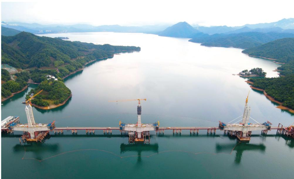
正在进行第三个主塔封顶施工的池黄铁路太平湖特大桥(6月29日摄,无人机照片)。太平湖特大桥是池黄铁路控制性工程,全长926.1米,其中主桥长788米,采用双塔三塔矮塔斜拉桥,两个主跨均为228米。池黄铁路全长约125公里,设计时速350公里,是武(汉)杭(州)快速铁路通道的重要组成部分。
