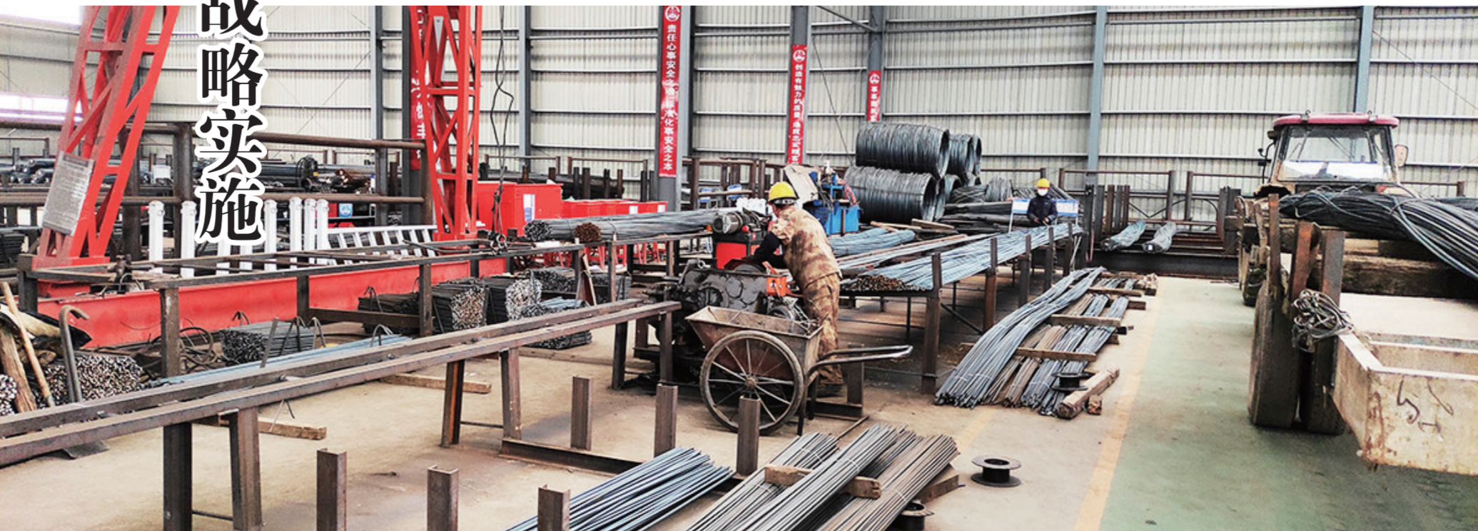
实施标准化施工，打造品质工程
