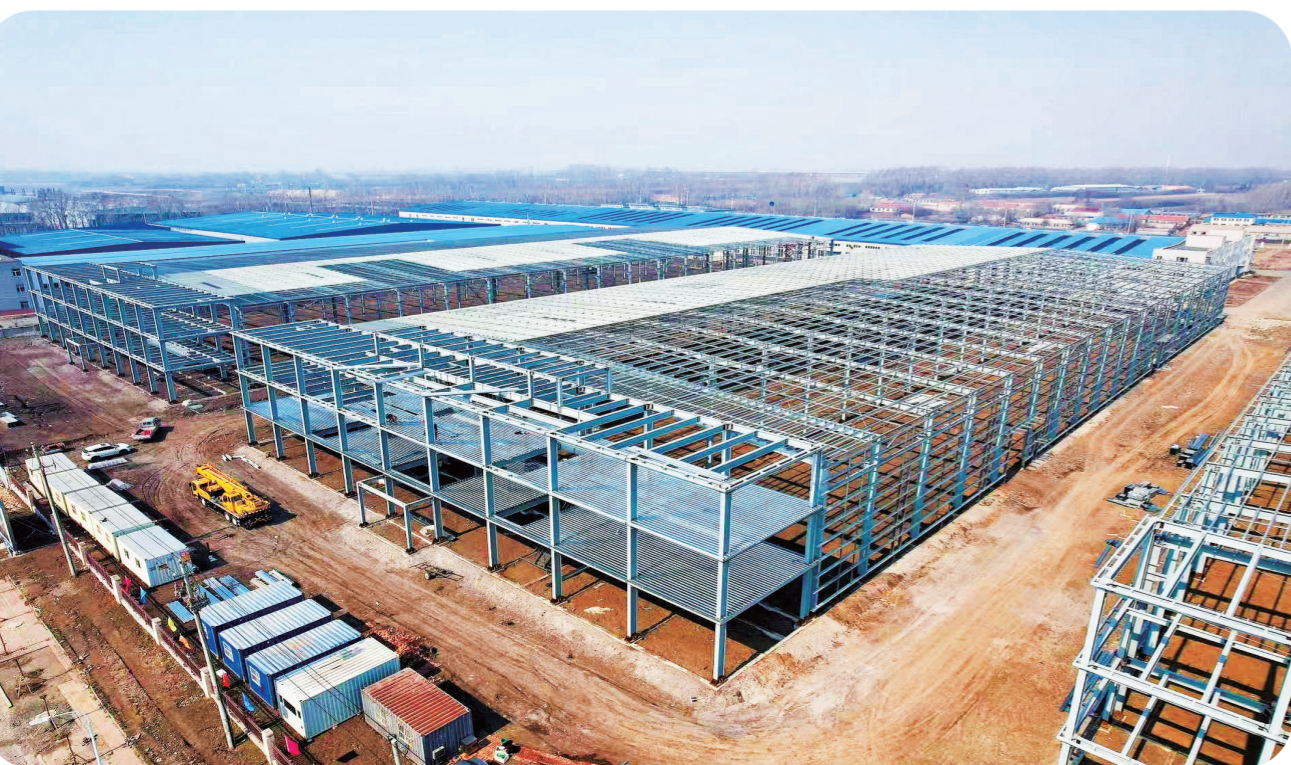
大梓科技项目建设现场
