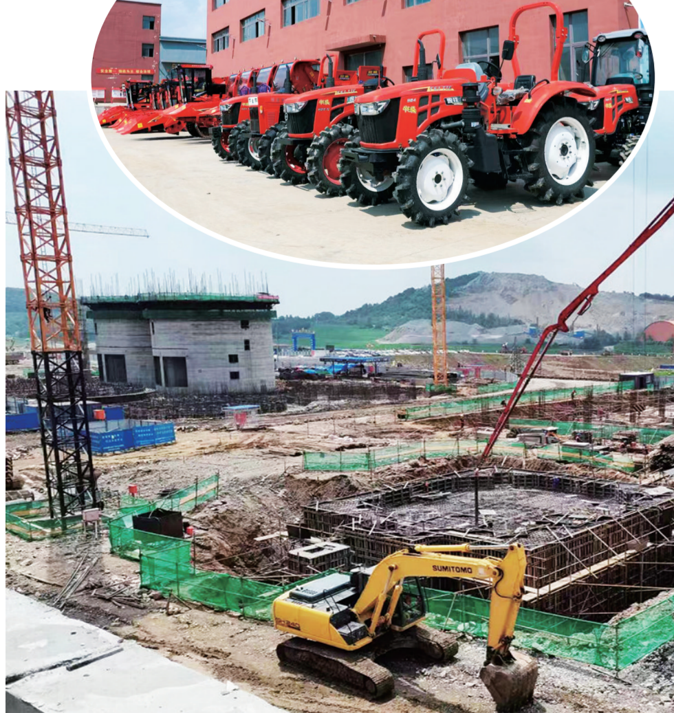
↑磐石市五金农机建材产业园内景。 ↓磐石市金隅冀东新型建材产业园项目施工现场。
