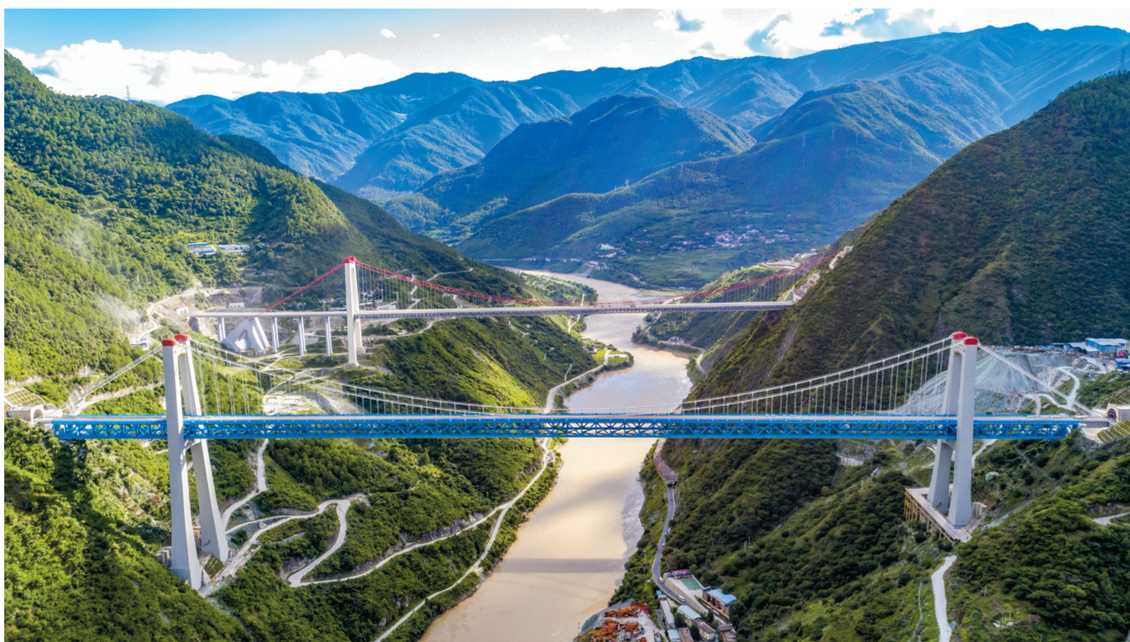
这是7月26日拍摄的丽香铁路金沙江特大桥(前),远处是丽香高速金沙江特大桥(无人机照片)。7月27日,丽香铁路全线控制性工程哈巴雪山隧道正洞中导洞贯通。丽香铁路全长约140公里,设计时速120公里,南起丽江市,向北跨越金沙江至香格里拉。建成通车后,云南丽江到香格里拉的时间将大大缩短,对补齐滇西北地区铁路网络、助推沿线经济社会高质量发展、促进民族团结和乡村振兴具有重要意义。新华社记者 陈欣波 摄
