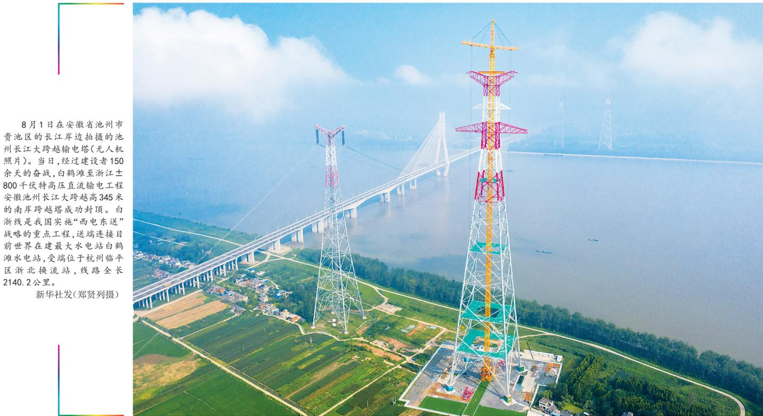
8月1日在安徽省池州市贵池区的长江岸边拍摄的池州长江大跨越输电塔（无人机照片）。当日，经过建设者150余天的奋战，白鹤滩至浙江±800千伏特高压直流输电工程安徽池州长江大跨越345米的南岸跨越塔成功封顶。白鹤滩是我国实施“西电东送”战略的重点工程，送端连接目前世界在建最大水电站白鹤滩水电站，受端位于杭州临平区浙江换流站，线路全长2140.2公里。
