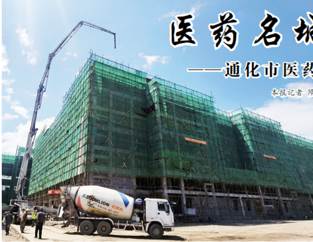
通化县安宇生物建设项目现场。本报记者 隋二龙 摄
