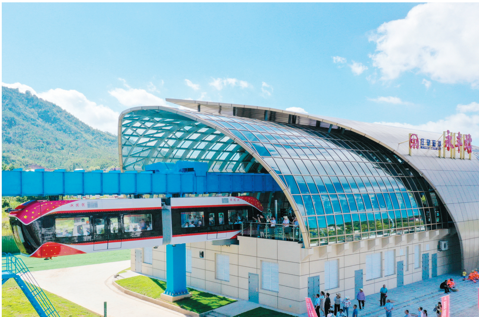
8月9日,“红轨”试验线列车驶出车站(无人机照片)。当日,国内首条稀土永磁磁浮轨道交通工程试验线——“红轨”,在江西兴国县正式竣工,并实现将稀土永磁磁浮技术与空轨技术结合,建成中低速、中低运量的新制式轨道交通系统。正线全长约800米,均为钢构高架线,磁浮列车采用2车编组,载客能力为座席32个、定员88人,最高设计运行速度为80公里每小时。新华社记者 胡晨欢 摄
