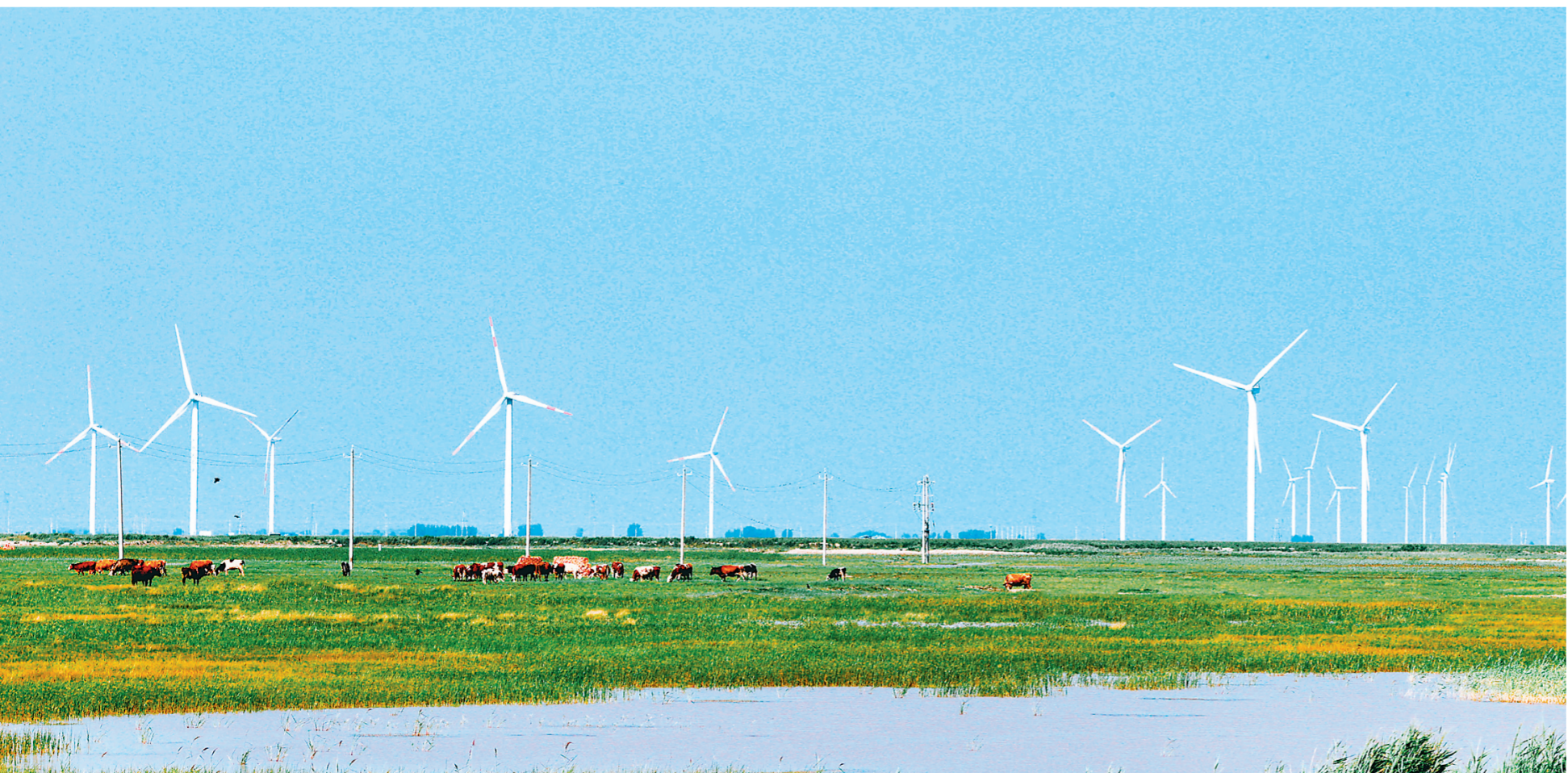
白城市紧紧围绕“一主六双”高质量发展战略,积极打造“陆上风光三峡”,不断强化新能源保障、氢能产业示范、新能源消纳、新能源装备制造“四大基地”建设,加快形成千亿规模的产业集群。图为位于大安市新平安镇的风力发电机组。
