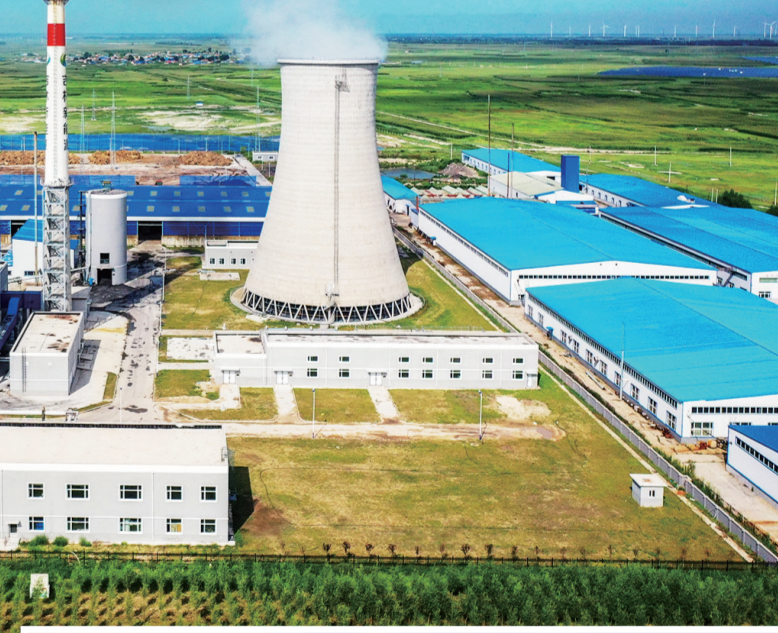
洮南上海电气风电装备制造产业园项目 李鹤明 摄
