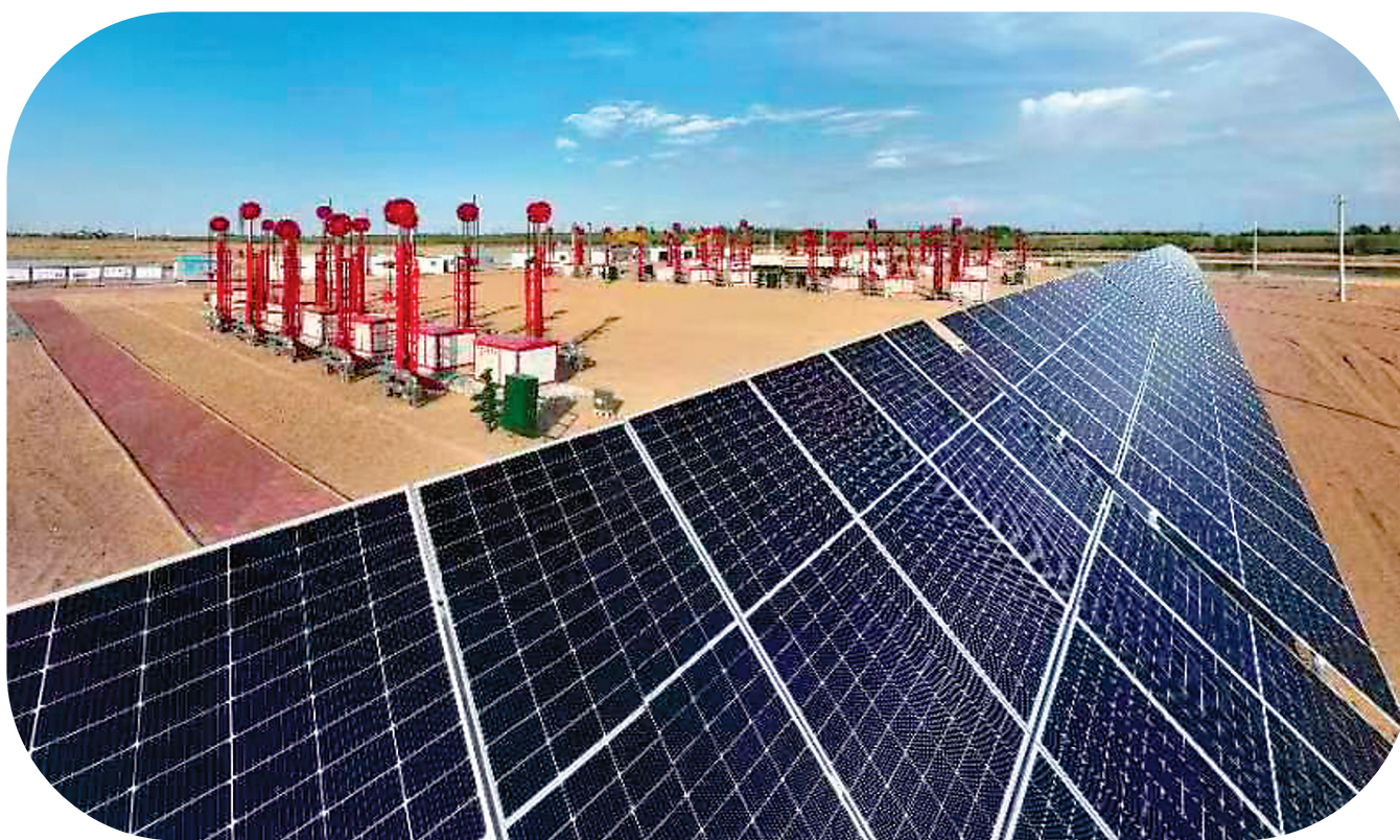
亚洲最大陆地采油平台——新立采油厂16号大井平台全部投产。
