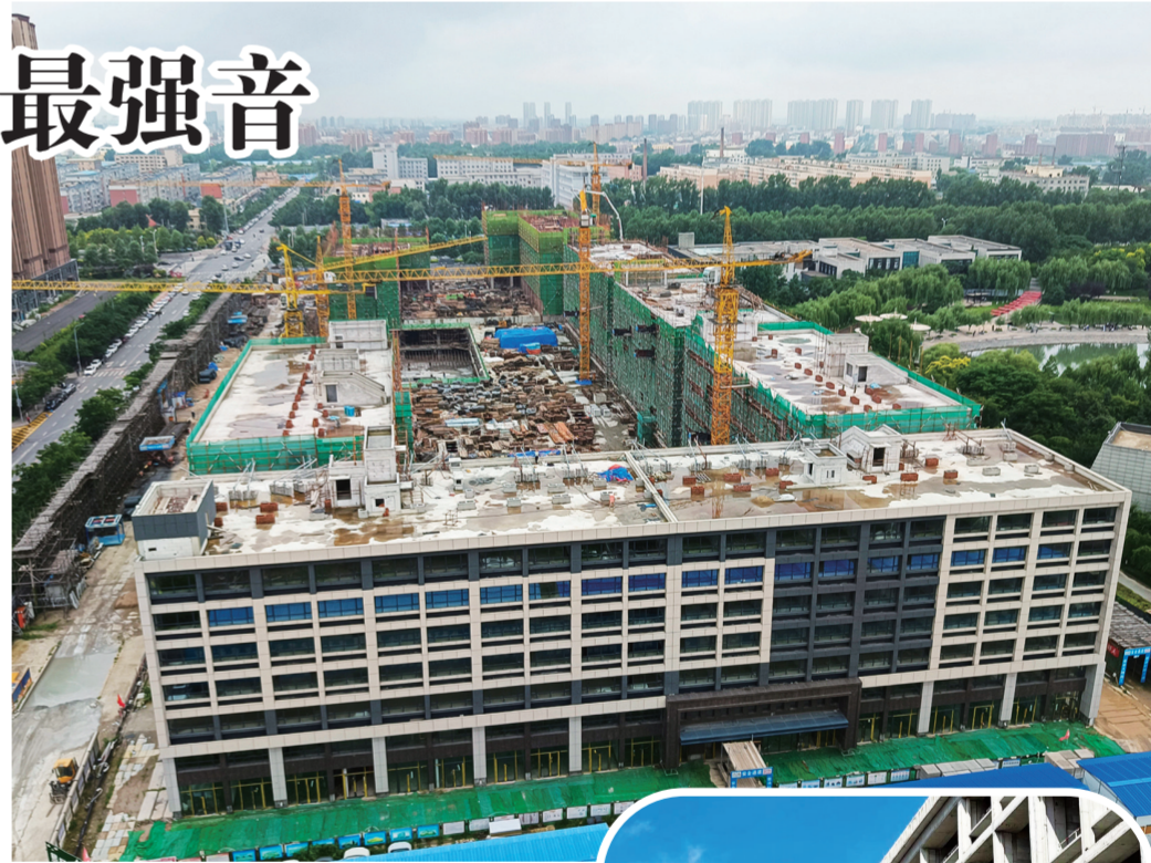
↑熙旺中心项目施工现场。
