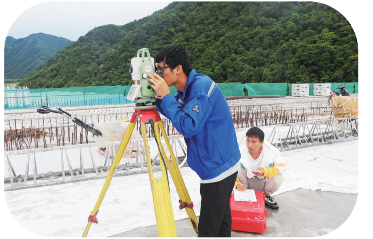
对石庙特大桥施工进行实时数据监测
