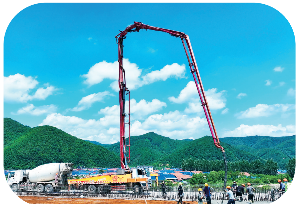
烟长高速采取歇人不歇机、24小时不间断推进节点工程施工
