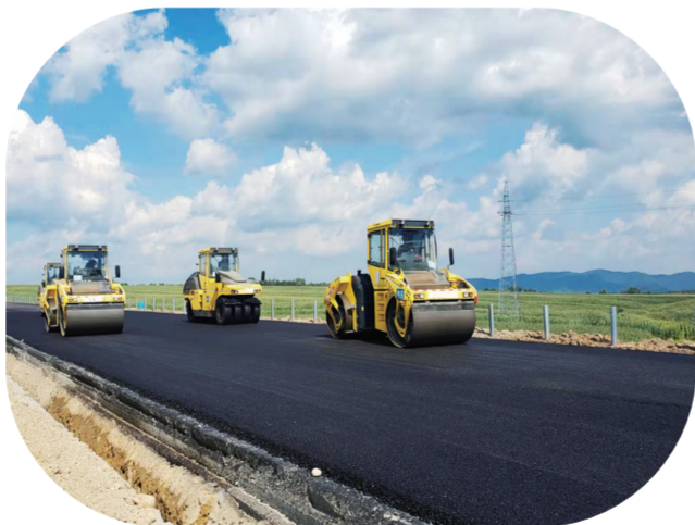
长春经济圈环线九台至双阳段加快推进路面摊铺施工
