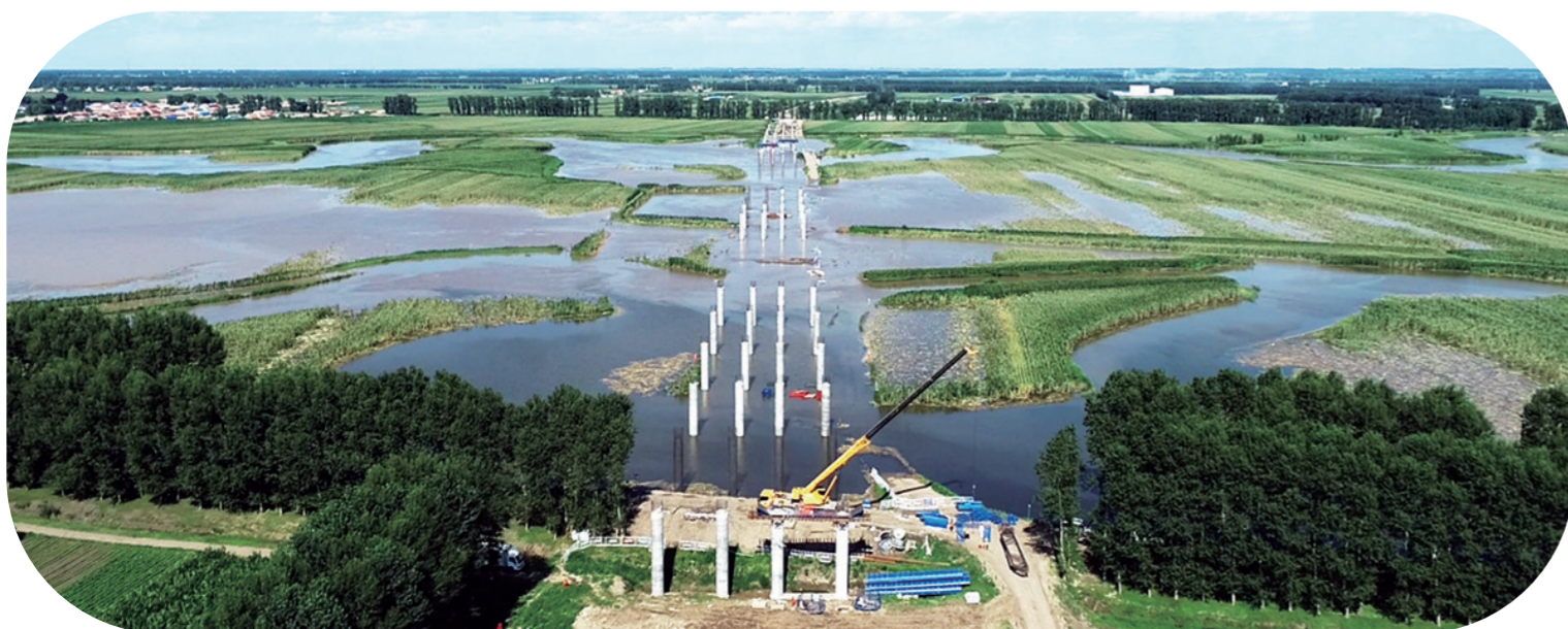
长春经济圈环线农安至九台段、双阳至伊通段项目伊通河特大桥下部结构施工
