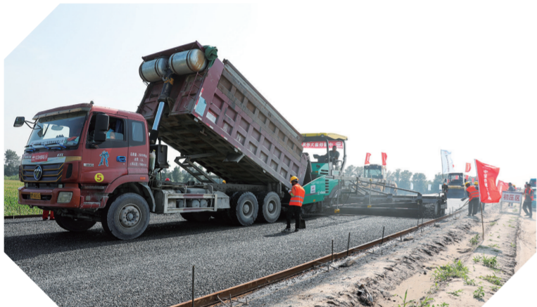
长太高速进入路面施工阶段
