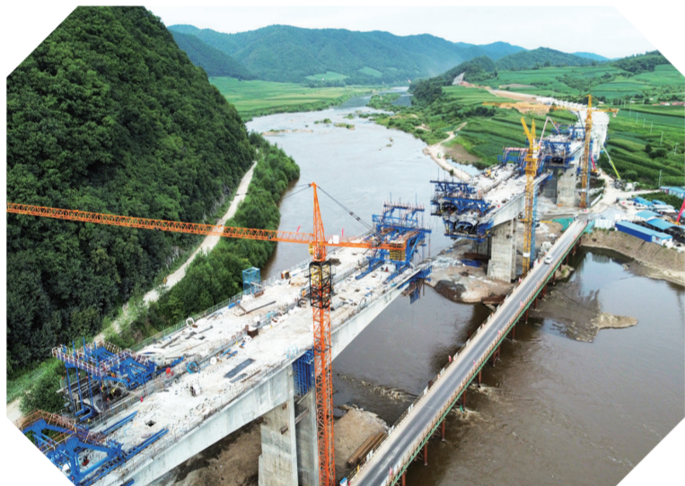
蒲烟高速东金沟松花江特大桥施工现场
