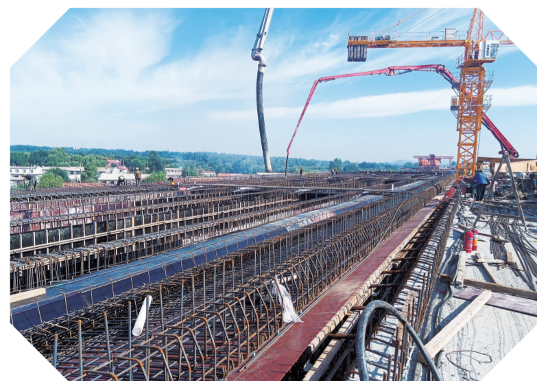
长春至自然村高速加快推进大桥施工
