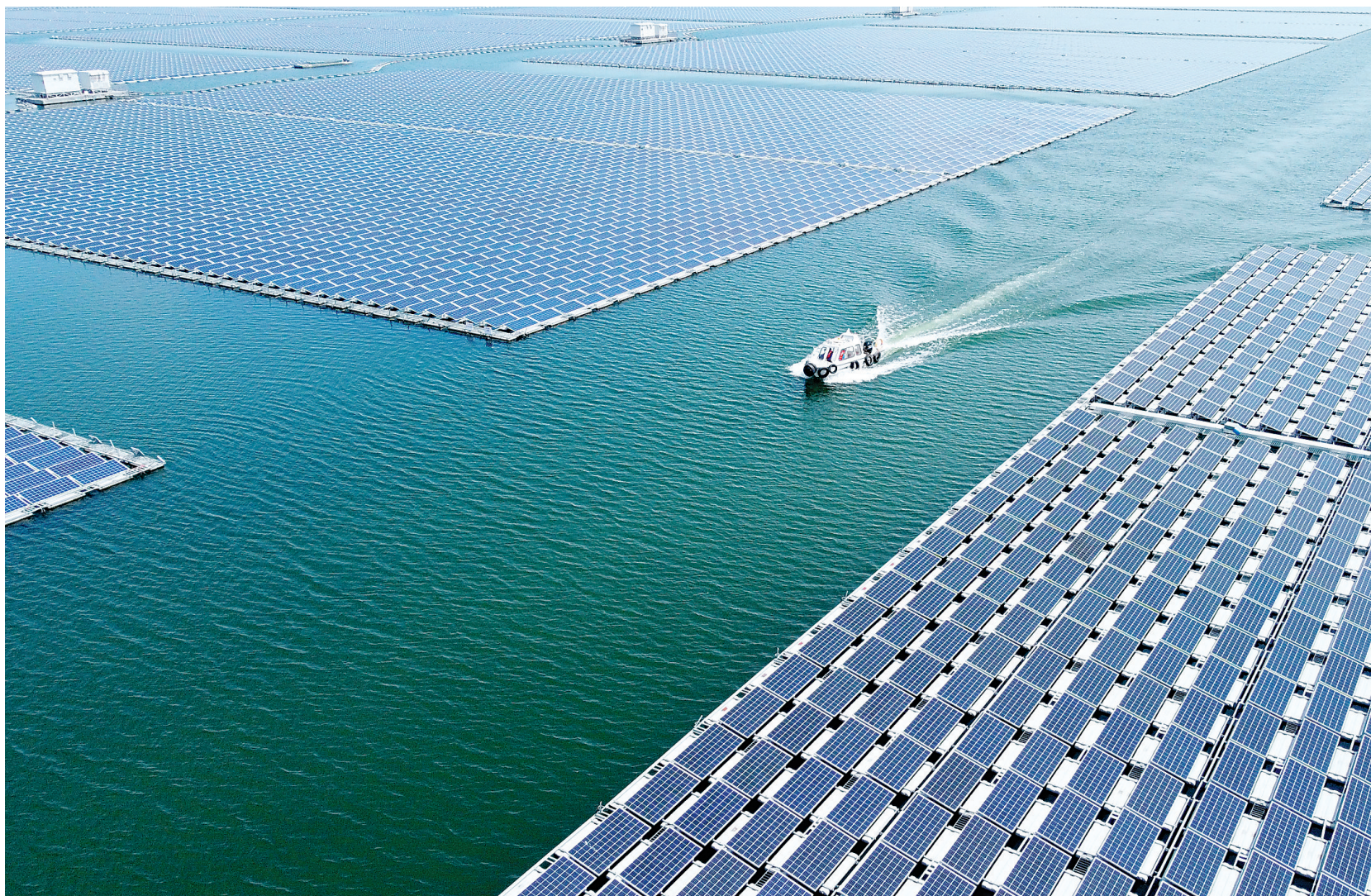
8月25日拍摄的颍上县毛圩水上光伏电站(无人机照片)。
