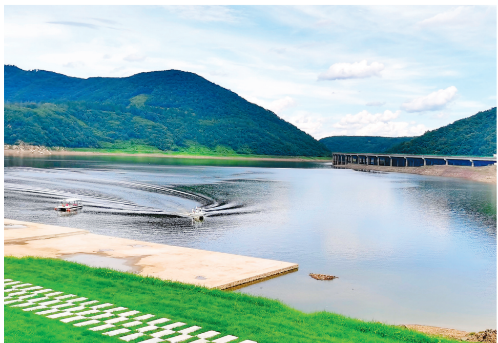
靖宇县花园口镇正身河生态保护修复工程正在积极推进二期建设,该项目的实施将有效增强河流沿岸及入湖口处生态系统的稳定性和生态环境的自净能力,对推动区域生态环境整治,促进当地旅游产业发展有着积极的作用。本报记者 丁研 摄
