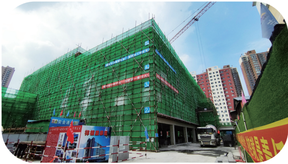
吉林中西医结合医院中药传承创新工程项目施工现场
